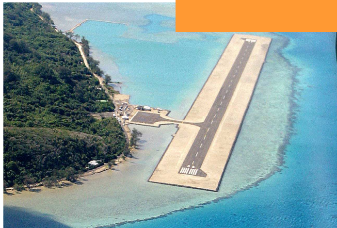
Aéroport de Raivavae
